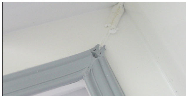
Вид сваренного уплотнения в углах после зачистки
